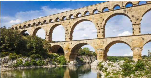
Le Pont du Gard (France)
